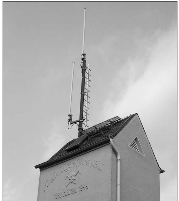
Abb. 2: Sendeanlage im Ortsteil Hennen, Hennenerstraße 45, 58640 Iserlohn, Höhe über NN 153 Meter.
